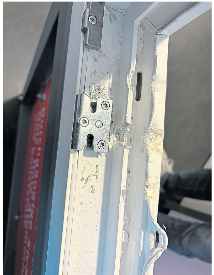
Auch wenn das Fenster neuerer Art deutliche Beschädigungen aufweist, so hält es den Hebelversuchen doch stand und lässt den Einbrecher nicht ins Haus.
