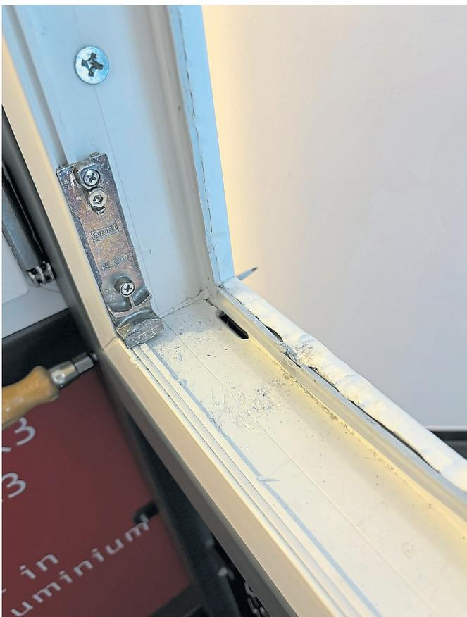
Fenster älteren Baujahres mit Rollzapfen stellen für Einbrecher keine große Herausforderung dar. Das Fenster ist schnell geöffnet, deshalb halten sich die Beschädigungen auch in Grenzen.
